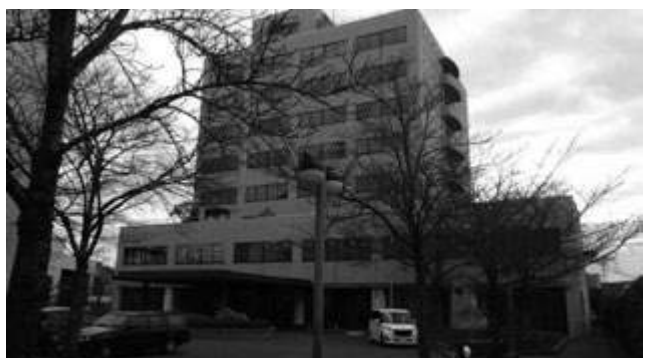
学舎の全景！ 近代的な建物で、設備バッチシ！
